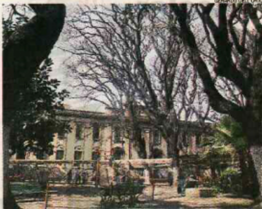
PLAZA. DEMOLERAN EL PABELLÓN PELLEGRINI Y PROTEGERÁN LOS ARBOLES.
